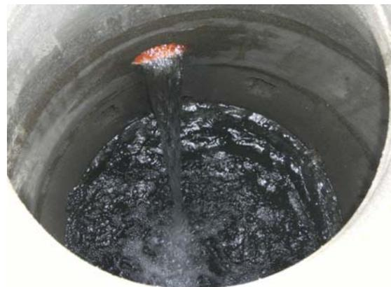
Photo 2 : Ouvrage terminé avec débit à infiltrer
