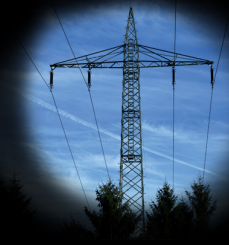
Wartung von Hochspannungsleitungen
