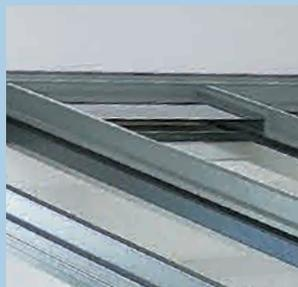
Beleuchtungsleisten mit integrierten Spots werden am Ende der Montage einfach von unten auf die Sparren geklipst. Die weiterführenden Kabel werden in einem eigenen Kabelkanal unter dem Wandanschluss verborgen.
