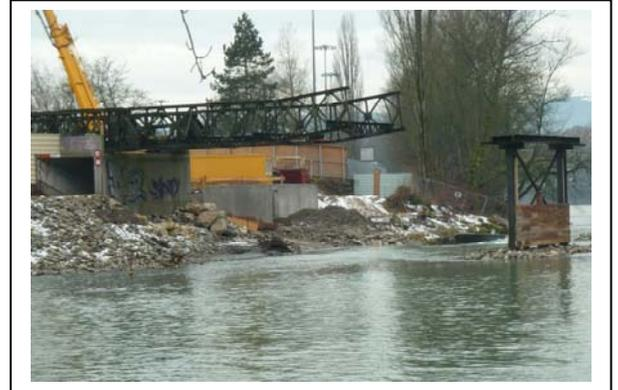
Photo 1 : Poussage du pont provisoire
