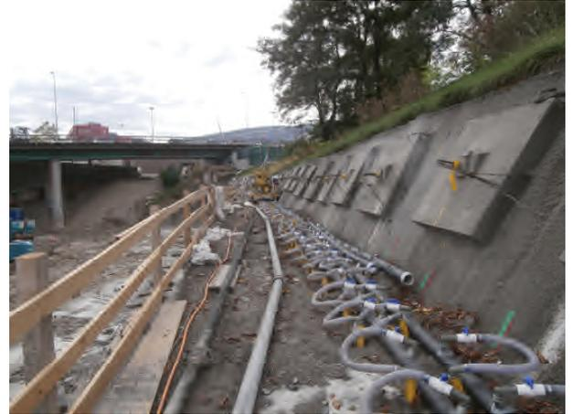
Photo 1 : Well points et plaques ancrées
