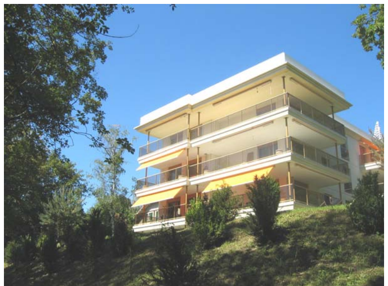
La façade Sud avec des balcons profonds liés à la dalle par les consoles isolantes
