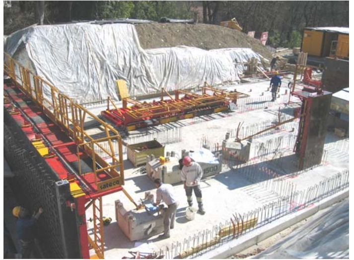
Construction du sous-sol – terrain en forte pente
