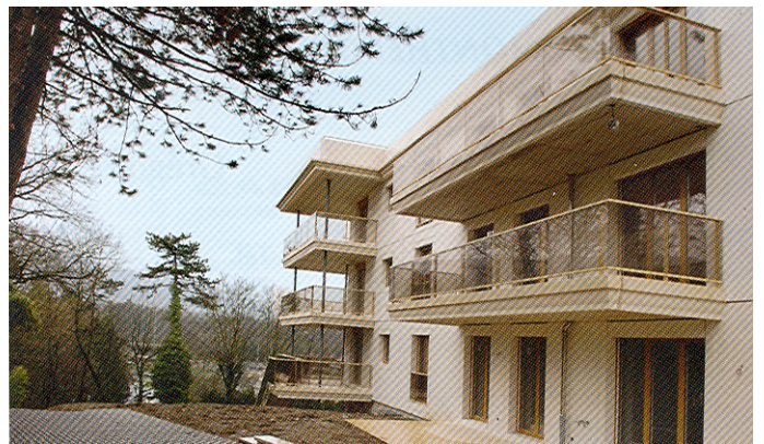
Façade Est du bâtiment en cours de travaux
