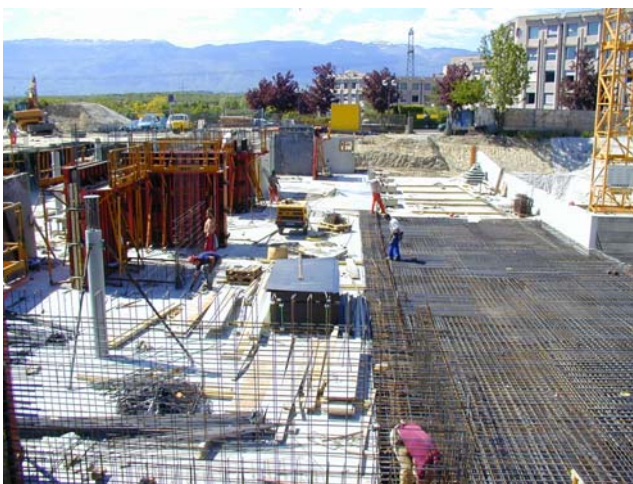
Phases de chantier
